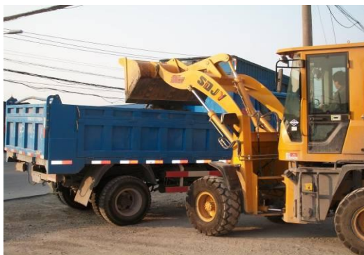
渣土倒入自卸式渣土清运车，清运渣土
