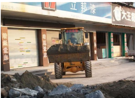
铲车现场清理渣土
