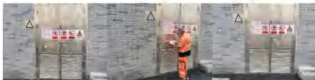
图-电箱保洁（作业前后）
