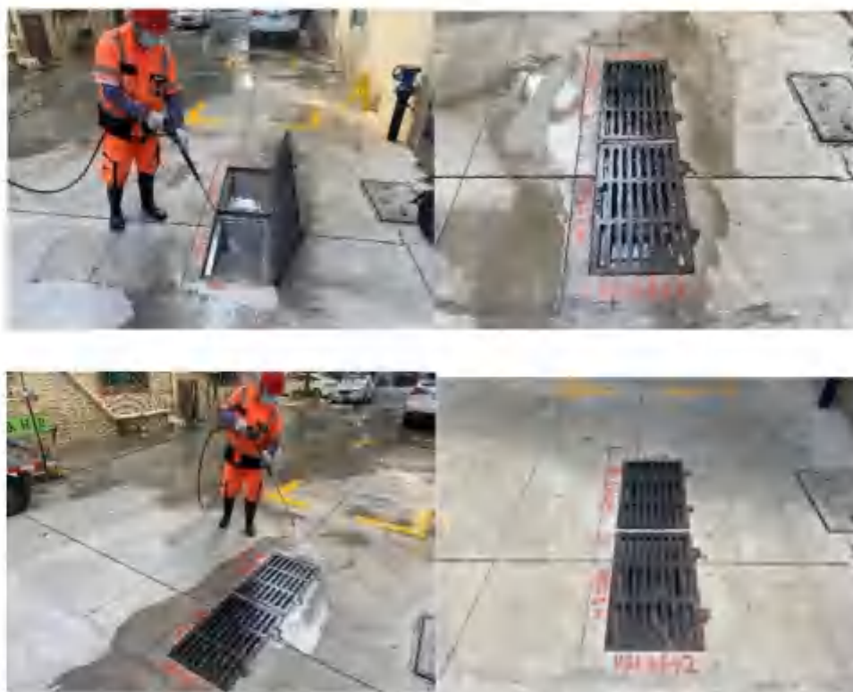
图-雨水篦子日常清洗保洁（作业前后）
