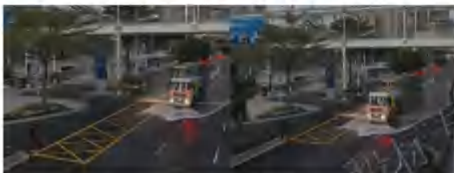
图-机动车道夜班“高压冲刷+机械清扫”作业模式
