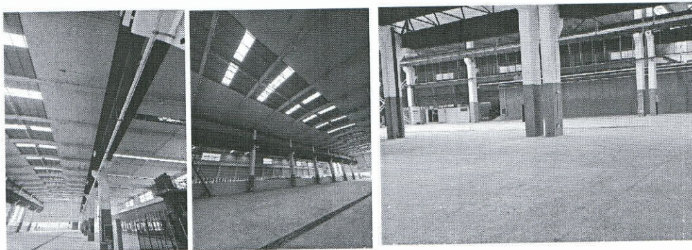
地面和柱面施工
